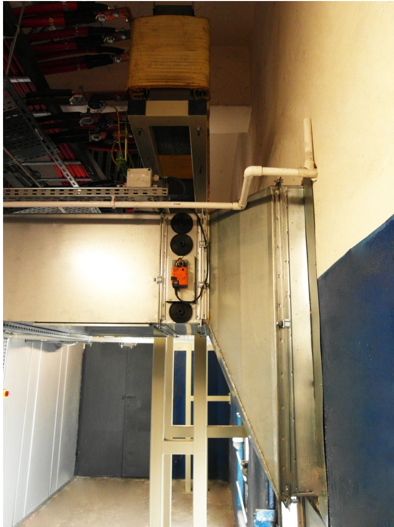
Rys.5. Układ wentylacji wymuszonej oraz dławiki obniżające
