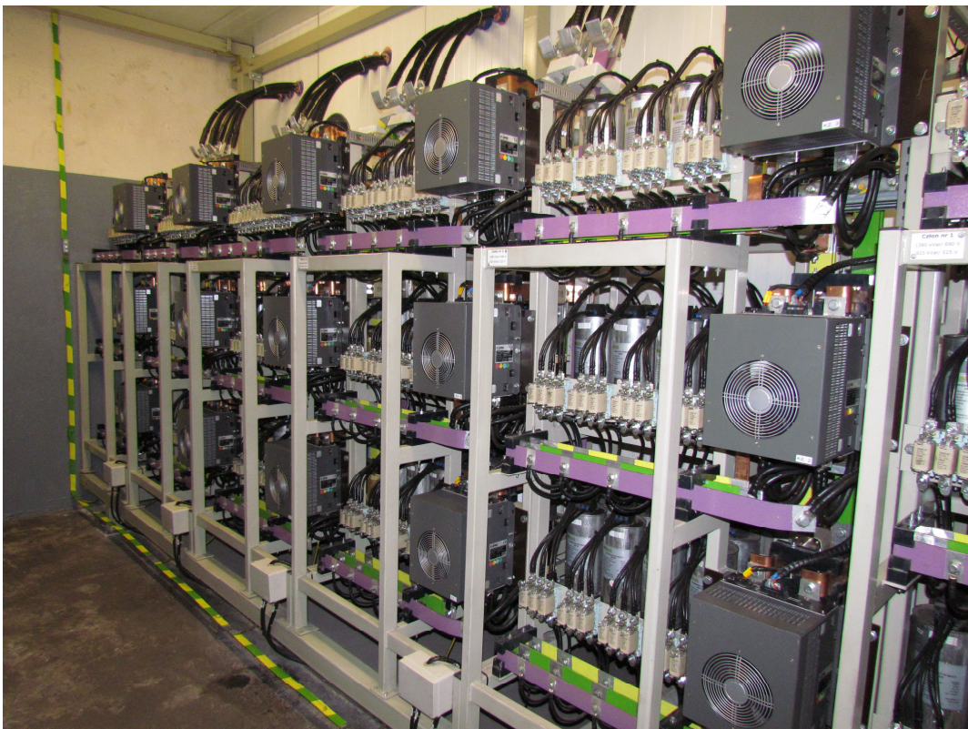
Rys.4. Człony kondensatorowe
